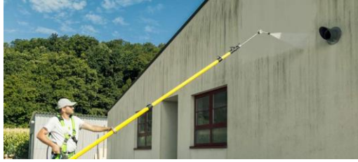
Fasado paruošimas http://cistime-fasady.sk
