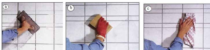
Siūlių užpildymo technologinės operacijos
